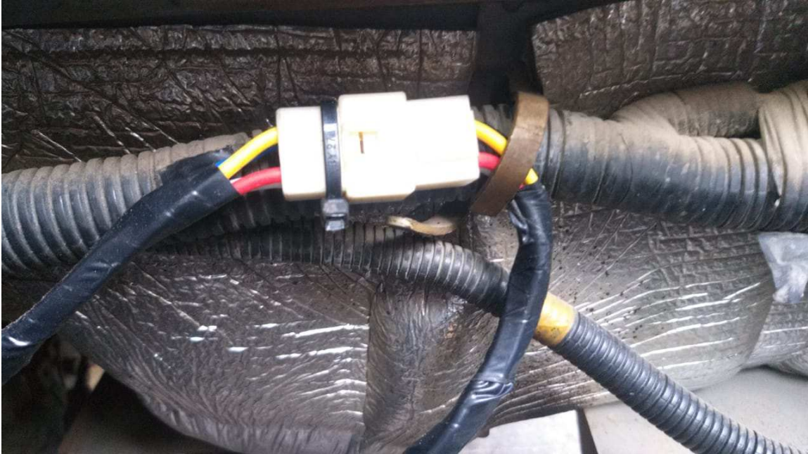
CONECTORES Y FUSILES E INSTALACION DE BOMBA ARREGLADOS
